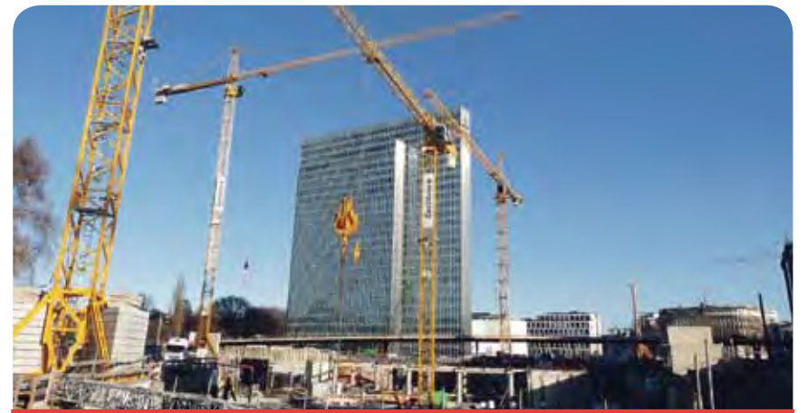
Kö-Bogen und Wehrhahnlinie - ein Milliardenloch - U81 folgt demnächst
